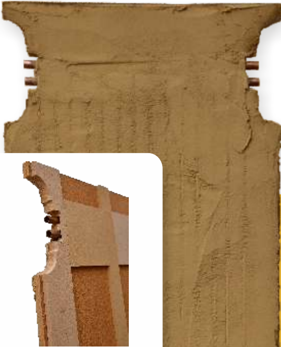
Die Verstärkung auf der Paneel-Rückseite nimmt zugleich die Sammel- und Verteilerrohre auf.
