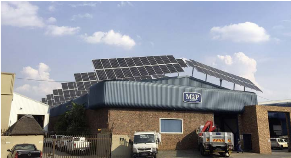
Bei dieser Fabrik in Südafrika wurden 20 Tracker S70 auf das Stahldach montiert.
