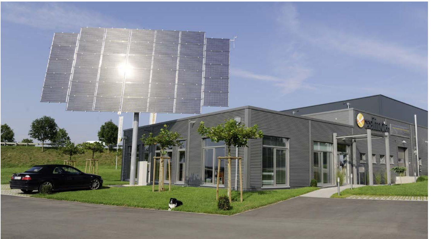
Der Fotomarkt Xalino in Herrenberg-Gültstein wirbt weithin sichtbar mit der Eigenversorgung durch Solarstrom.
