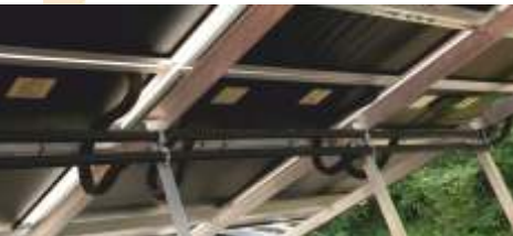
Modulrückseite mit Hydraulik, aufgeständert (Montagebeispiel)
